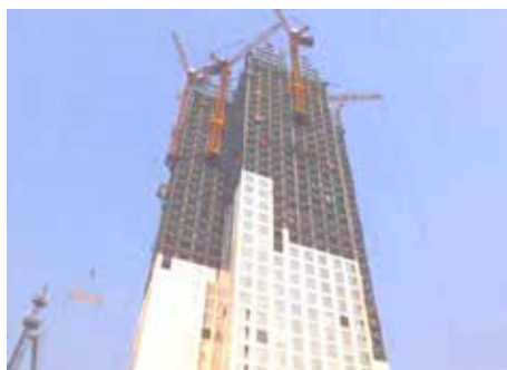
Рис. 5. Комплекс, будівництво технологією модульних блоків якого зайняло 19 днів. Китай
