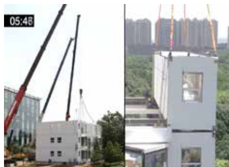
Рис. 6. Зведення житлового будинку з модульних блоків. Китай
